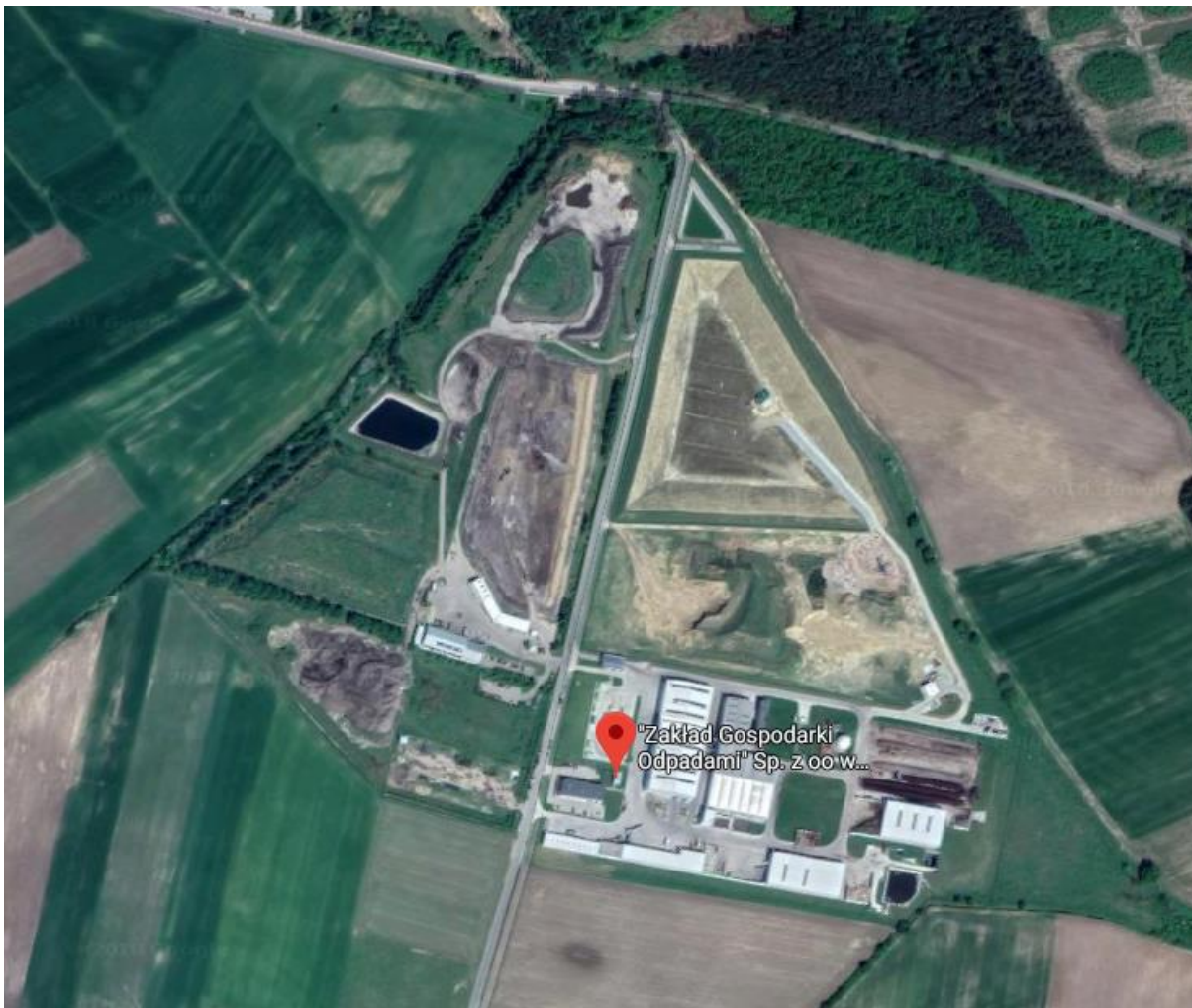
Ryc. 2. Orientacyjna lokalizacja obiektów (uwaga: widoczne zagospodarowanie terenu może być nieaktualne, stan faktyczny może różnić się od przedstawionego na powyższym zdjęciu satelitarnym, potencjalny wykonawca winien dokonać wizji terenowej obszaru planowanego przedsięwzięcia przed złożeniem oferty)
